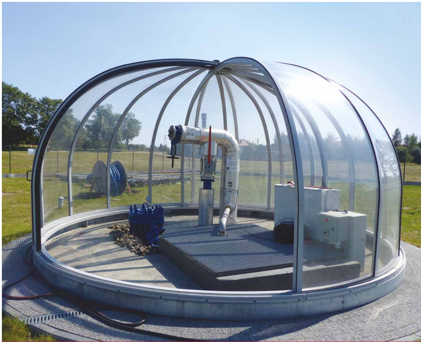
Głowica otworu geotermalnego Poddebice GT-2, głębokość otworu to aż 2101 m, a temperatura wody na wypływie wynosi 71 st. C
