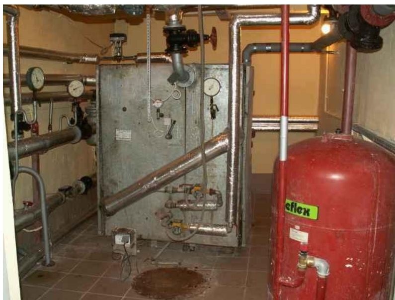
Rys.28. Wymiennik C.W.U. (wraz ze zbiornikiem wody ciepłej)
