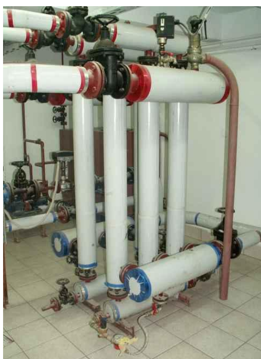
Rys.26. Wymienniki C.O. i C.W.U. (wraz ze zbiornikiem ciepłej wody)
