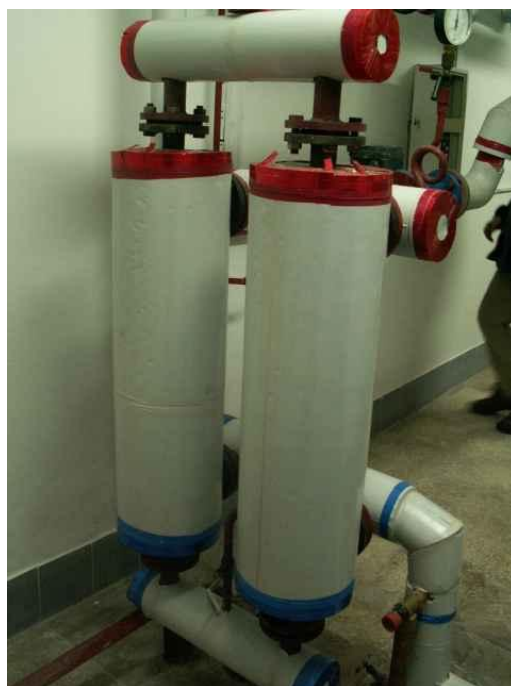
Rys.30. Wymiennik C.O.
