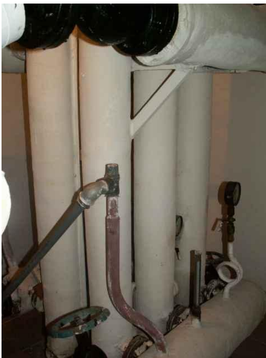
Rys.35. Wymienniki C.O. i C.W.U. (wraz ze zbiornikiem ciepłej wody)
