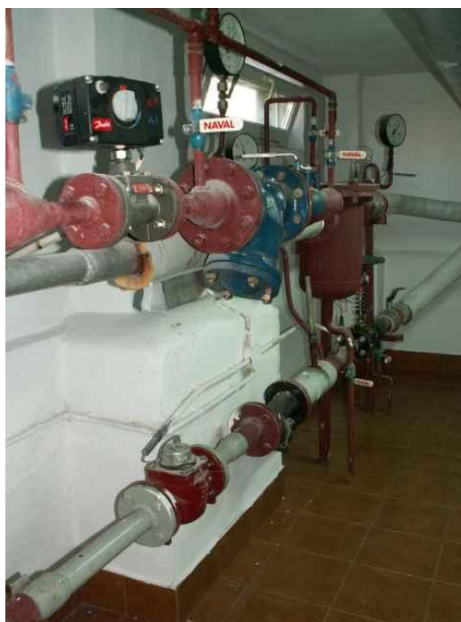
Rys.10. Zawór regulacyjny oraz przepływomierz
