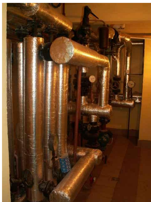
Rys.27. Wymiennik C.O.
