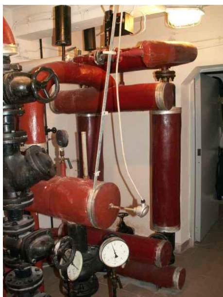
Rys.34. Wymienniki C.O. i C.W.U. (wraz ze zbiornikiem ciepłej wody)
