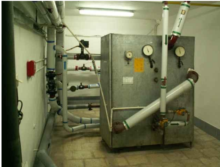
Rys.31. Wymiennik C.W.U. (wraz ze zbiornikiem wody ciepłej)
