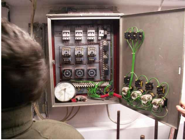
Rys.6. Szafka z trzema zegarami do ustawiania czasów pracy pomp
