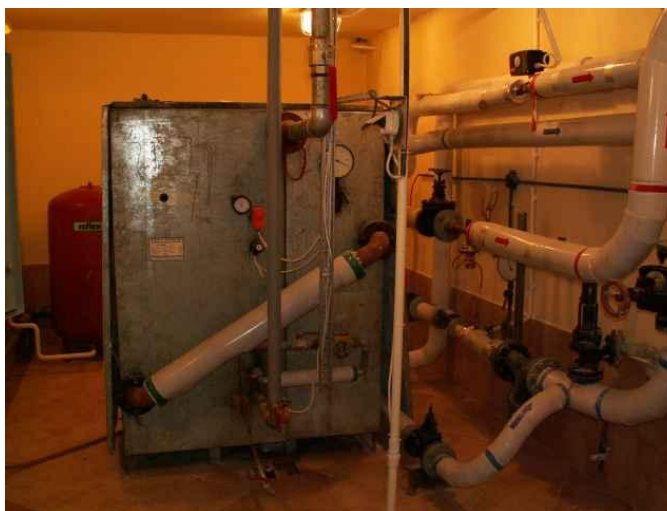
Rys.36. Wymienniki C.O. i C.W.U. (wraz ze zbiornikiem ciepłej wody)
