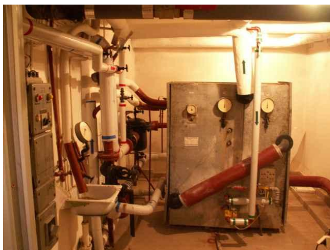
Rys.34. Wymienniki C.O. i C.W.U. (wraz ze zbiornikiem ciepłej wody)
