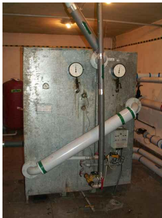
Rys.35. Wymienniki C.O. i C.W.U. (wraz ze zbiornikiem ciepłej wody)
