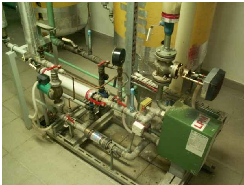
Rys.24. Kompaktowy wymiennik ciepła C.W.U.
