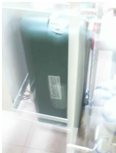
Rys.19. Kompaktowe wymienniki C.O. i C.W.U.
