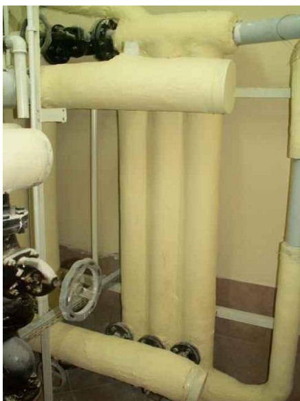
Rys.36. Wymienniki C.O. i C.W.U. (wraz ze zbiornikiem ciepłej wody)
