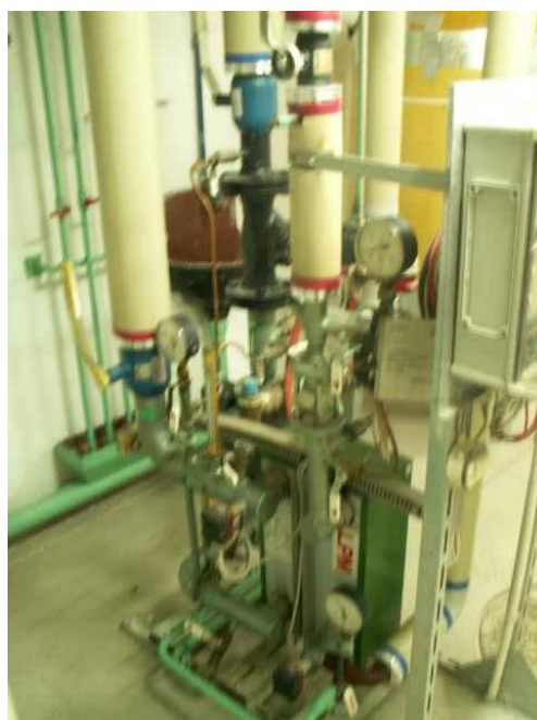
Rys.23. Kompaktowy wymiennik ciepła C.O.
