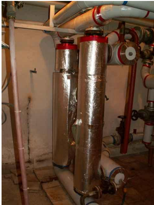
Rys.21. Wymienniki C.O. i C.W.U. (wraz ze zbiornikiem ciepłej wody)
