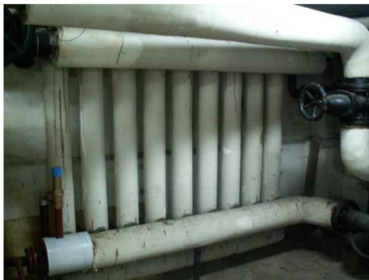
Rys.12. Wymiennik ciepła C.O.
