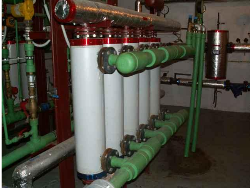
Rys.38. Wymiennik C.W.U.
