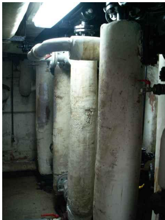
Rys.13. Wymiennik ciepła C.W.U.
