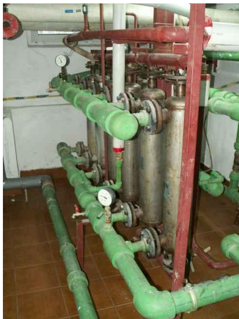
Rys.8. Wymiennik ciepła C.W.U. piwnica – strona lewa
