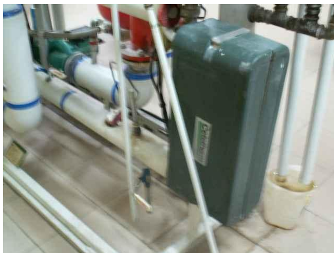
Rys.19. Kompaktowe wymienniki C.O. i C.W.U.
