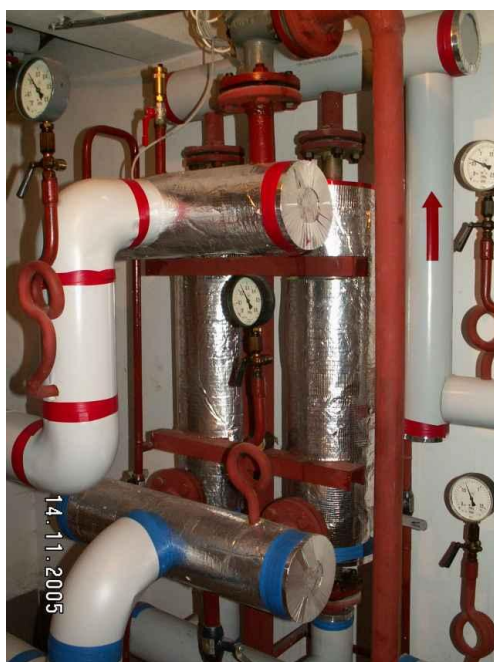
Rys. 4. Wymiennik ciepła C.O.
