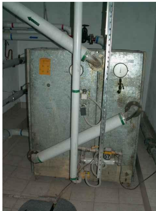
Rys.26. Wymienniki C.O. i C.W.U. (wraz ze zbiornikiem ciepłej wody)
