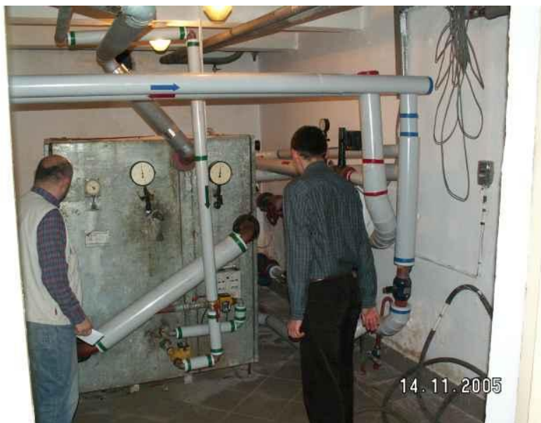
Rys. 3. Wymiennik ciepła C.W.U.
