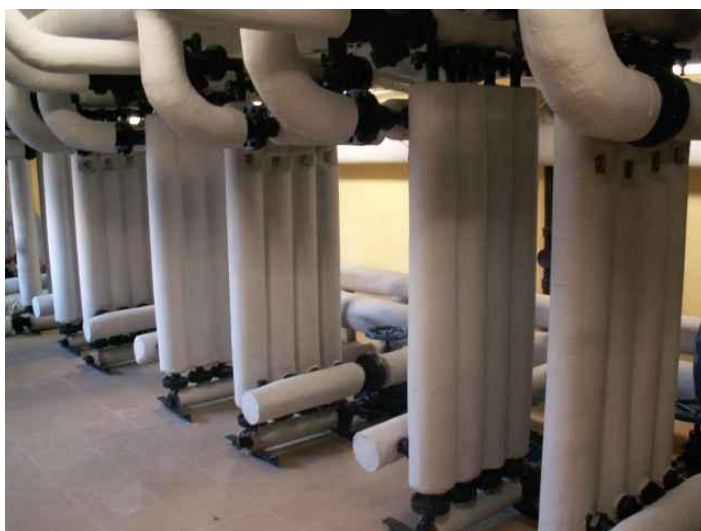
Rys.40. Wymiennik C.O.
