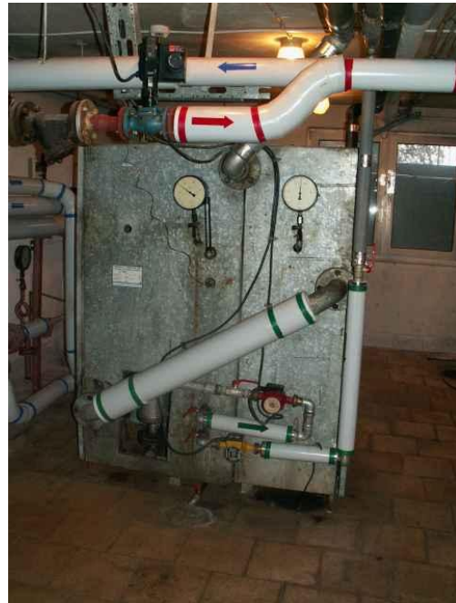
Rys.21. Wymienniki C.O. i C.W.U. (wraz ze zbiornikiem ciepłej wody)
