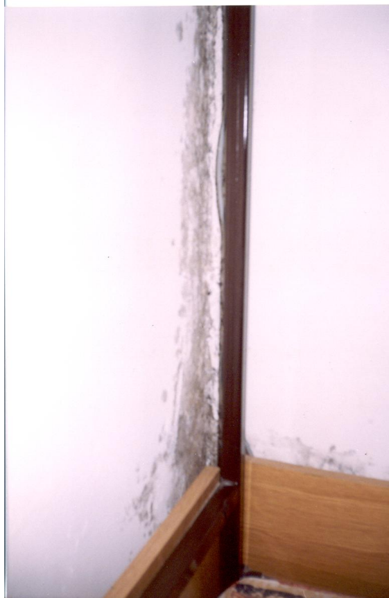
Rys.17.Zdjęcie zagrzybionego rogu pokoju nr 017
