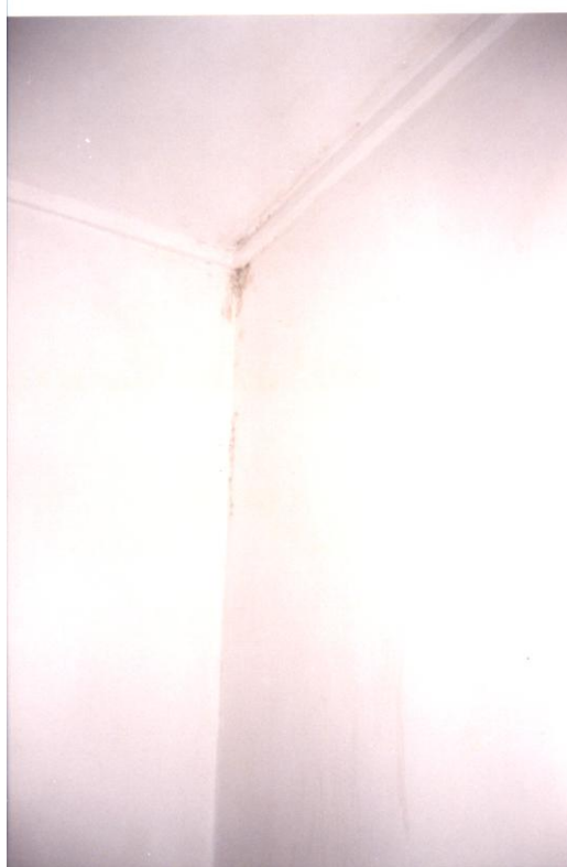
Rys.21. Obraz grzyba po kilku dniach od jego pojawienia się w rogu pokoju- Pokój 403
