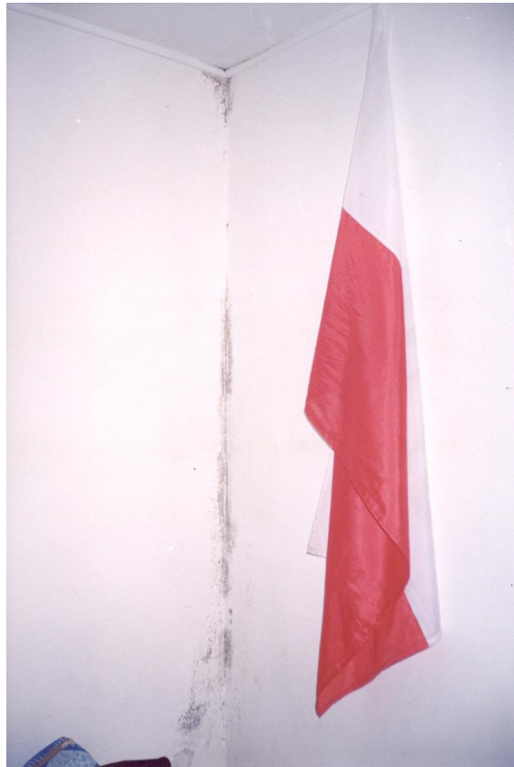
Rys.18. Obraz zagrzybionego rogu pokoju- Pokój 318
