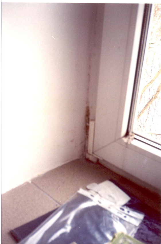
Rys.23. Faz początkowa pojawienia się wykwitu-”przyokienny” grzyb w pokoju 418
