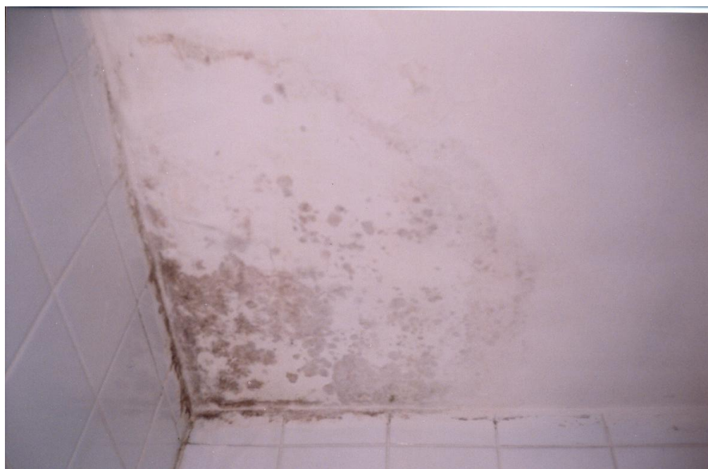
Rys.36. Zagrzybiona powierzchnia sufitu w sanitariacie 212
