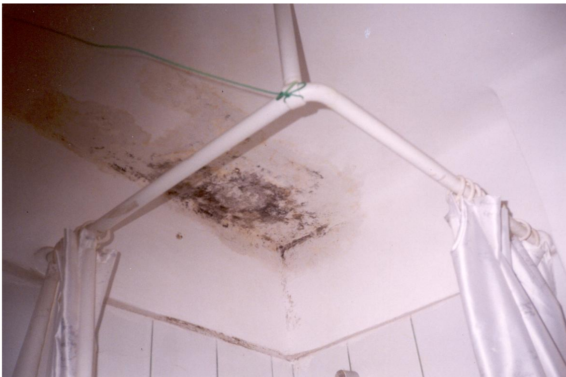
Rys. 1. Obraz zmiany pleśniowo – grzybowej w łazience przy pokoju 408 b
