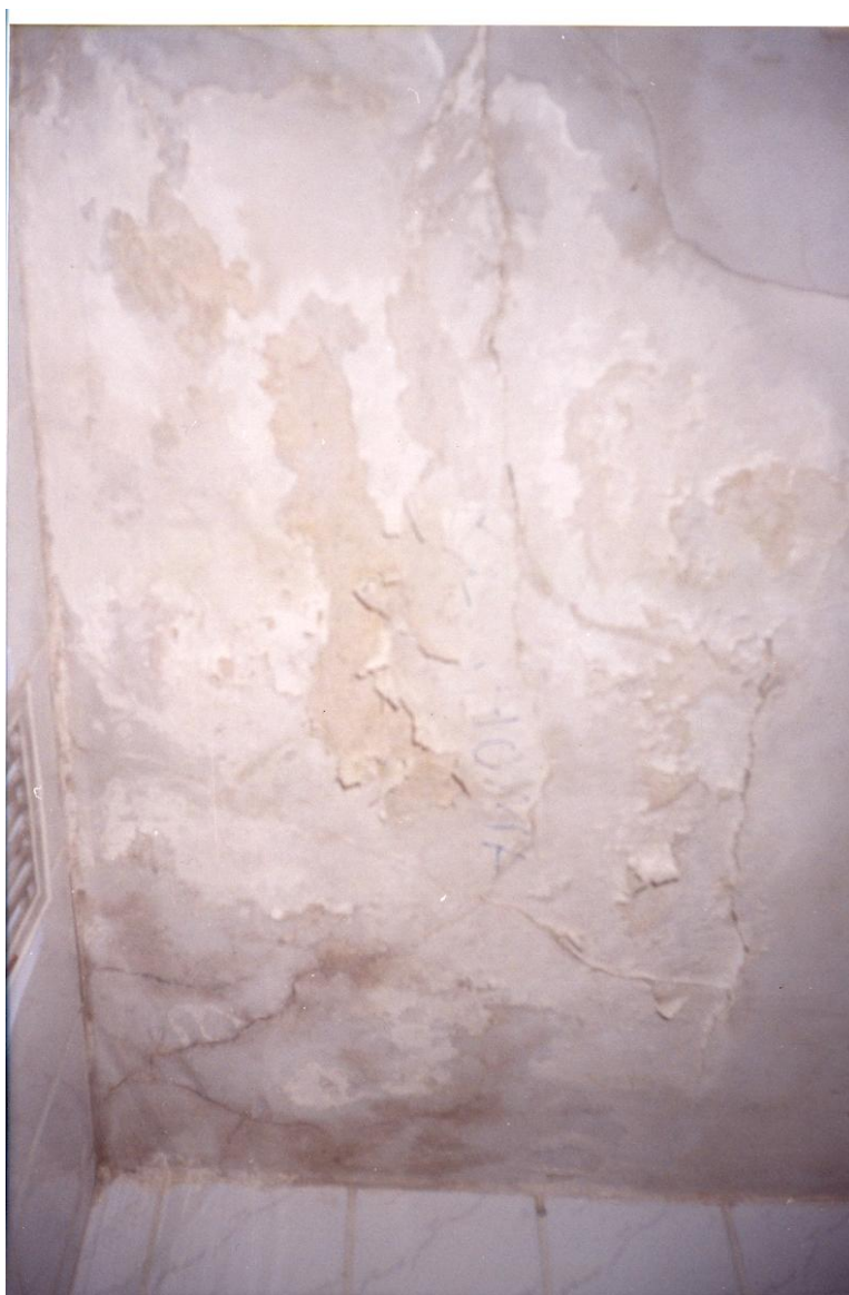
Rys.9.Obraz zmienionej powierzchni sufitu w sanitariacie -w aneksie 1111
